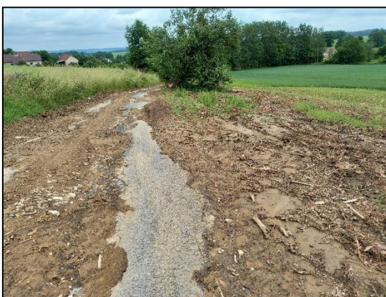
Obrázek 9: Ukázky škod na komunikacích (foto: me.vumop.cz)
